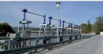
Der ADE-Elektro-Hubzylinder als vollständig gekapselte, elektromechanische Antriebseinheit besteht prinzipiell aus Antriebsmotor, Gewindetrieb mit Lagerung, Gehäuserohr sowie der aus- und einfahrenden Kolbenstange als äußeres Kraftübertragungselement. Seine wesentlichen Vorteile gegenüber den bisherigen, herkömmlichen Antriebsvarianten an der Wasserstraße werden dokumentiert durch zahlreiche Referenzen im Bereich Stahlwasserbau.
